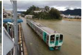
平成23年9月台風15号による高潮被害（東かがわ市）
