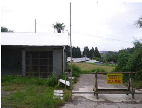
関係者以外立ち入り禁止看板の設置
