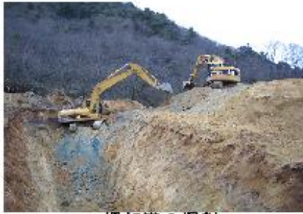
埋却溝の掘削
