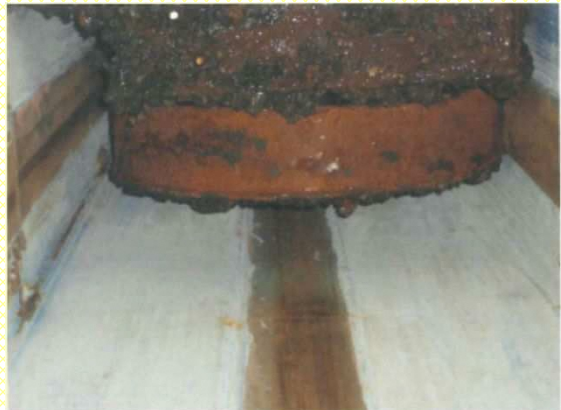
ローラの発錆及び腐食
