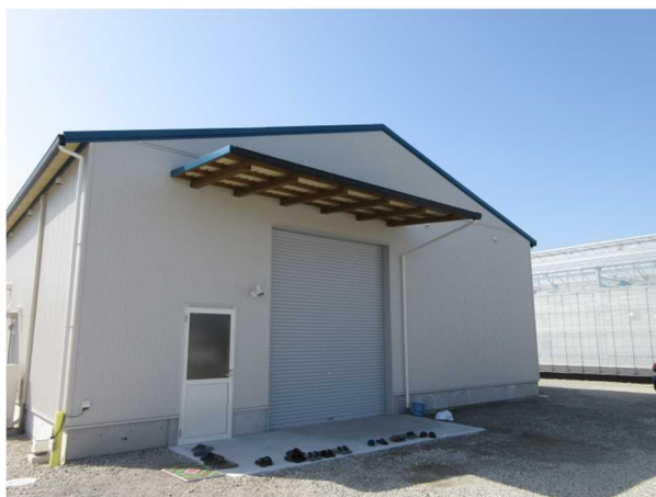
集出荷施設の整備
