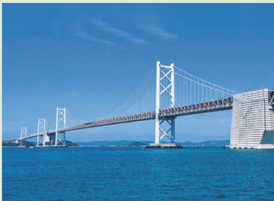
香川県と岡山県を結ぶ本州四国連絡橋「瀬戸大橋」
