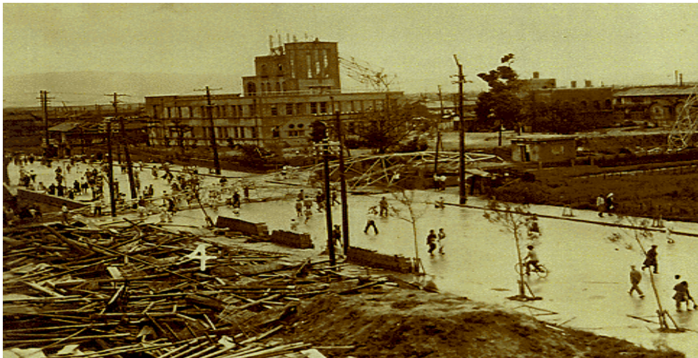
室戸台風の被害：昭和9年(1934. 9. 21)
