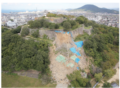
丸亀城跡南西部石垣崩落 丸亀市教育委員会提供
