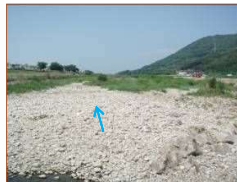
写真① 下流(国道11号付近)
