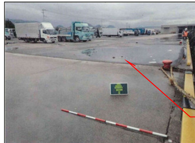
水溜まりの解消 舗装の打換え
