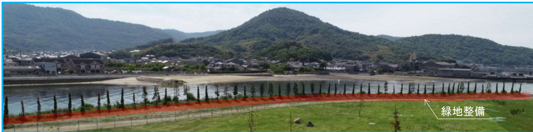
修景緑地の整備状況(撮影方向からの写真)
