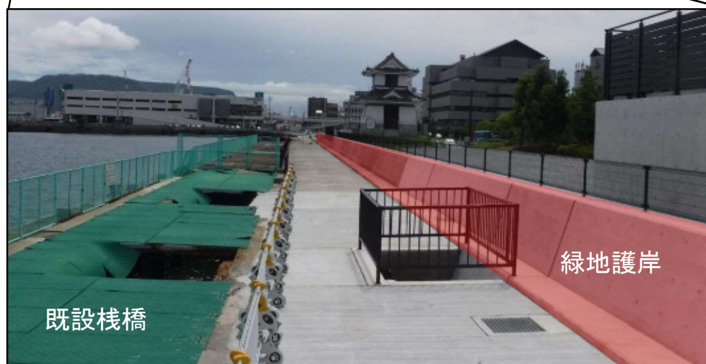
護岸整備状況
