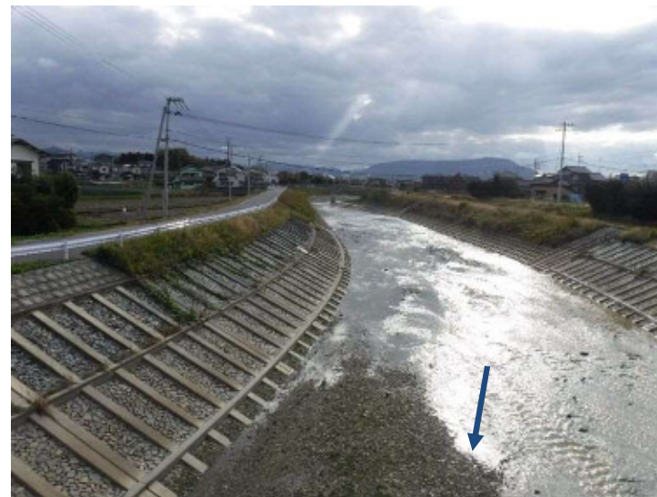
大東川改修後
