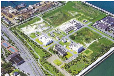
金倉川浄化センター全景
