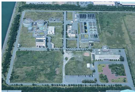
大東川浄化センター全景
