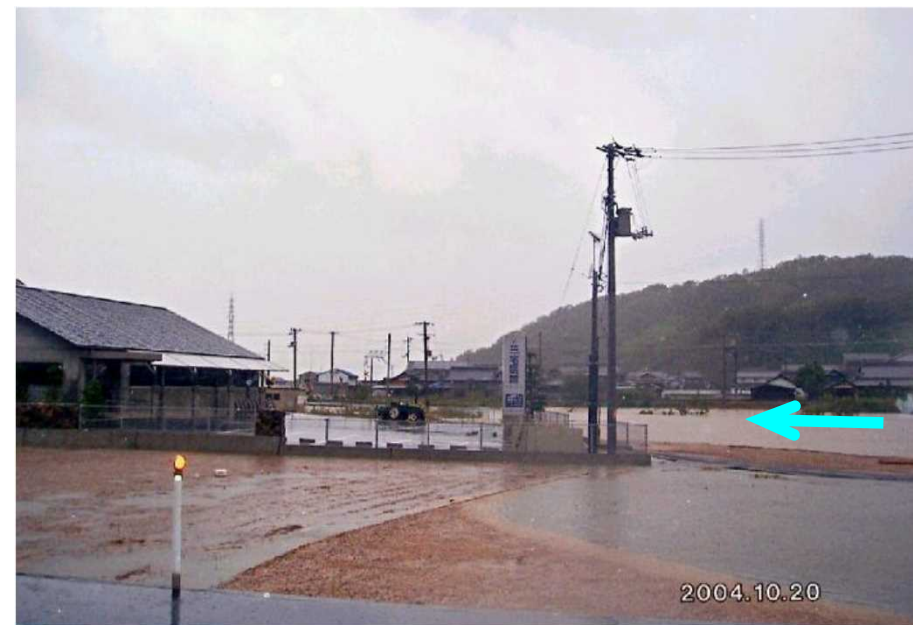
平成16(2004)年 浸水状況(台風23号)
