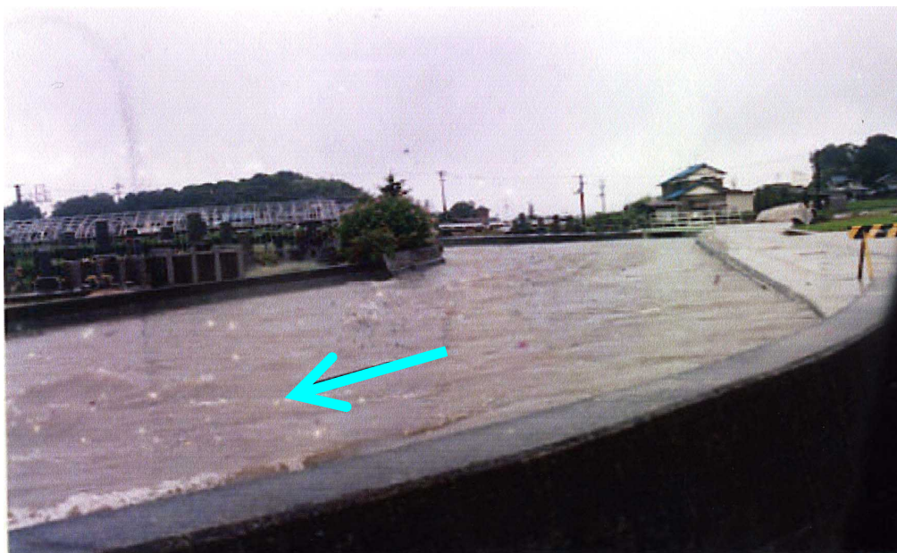
平成2(1990)年 浸水状況(台風19号)
