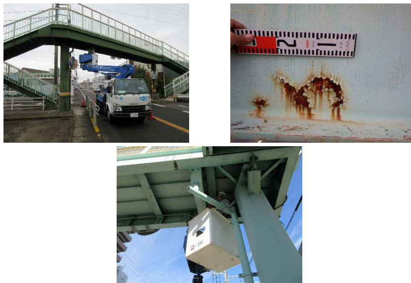
図 4.1 定期点検の様子
