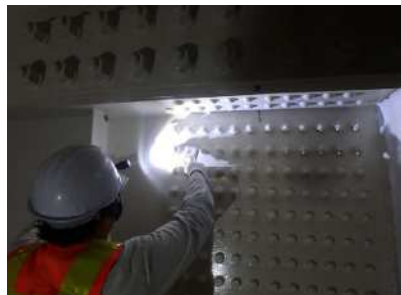
図 4.1 定期点検の様子
