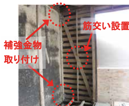
木造住宅の耐震改修
