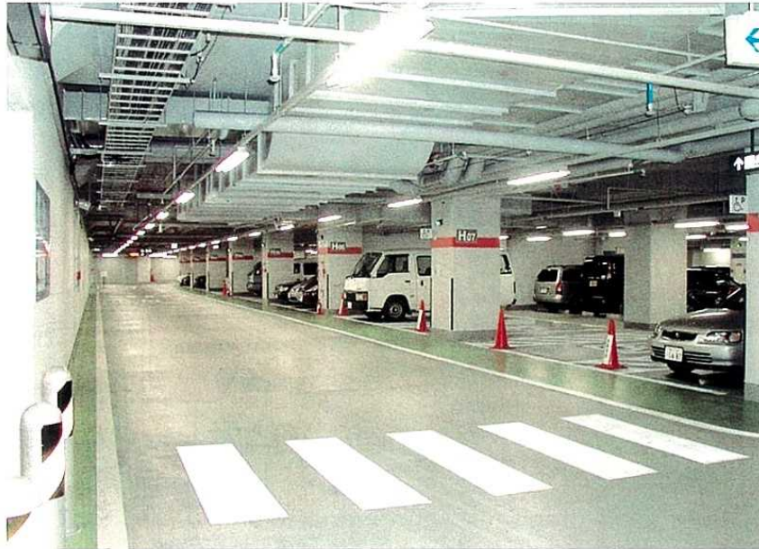
駅前広場地下駐車場
