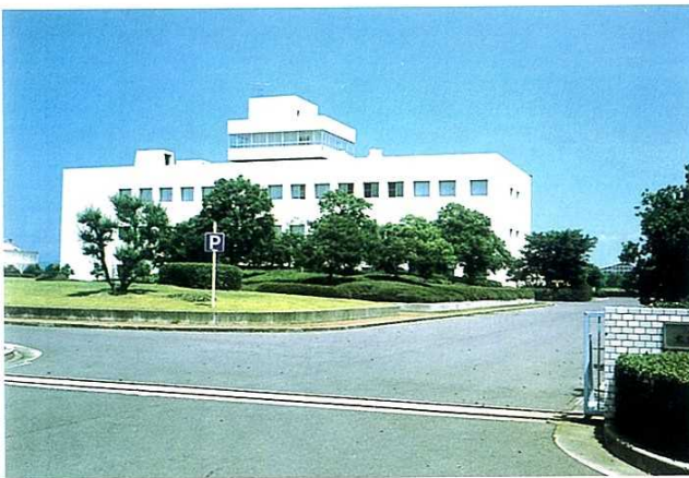
大東川浄化センター
