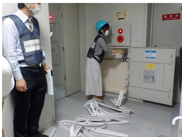
職員が各役割に応じた災害対応行動を確認 （初期消火班）
