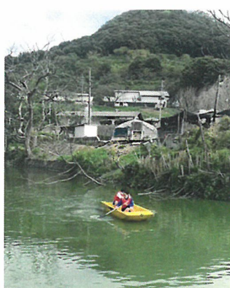
ため池の防鳥テープ設置
