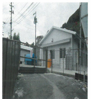
フェンスの設置
