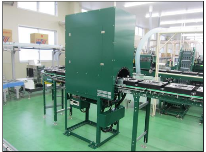
選別設備（重量・外観センサー）
