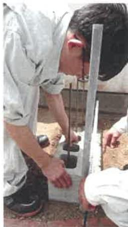
薪を焼く火床とピザを焼く焼き床を、耐火セメントを用いて型枠で作りました。窯の製作作業では、まず、コンクリートブロックを積んで窯を載せる基礎を作りました。この作業では、水平を見ながら慎重にブロックを積み、丁寧に目地入れを行うように気をつけました。
