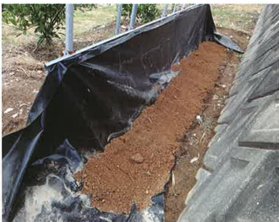
おもり補強の状況 (止水シート埋め込み型)
