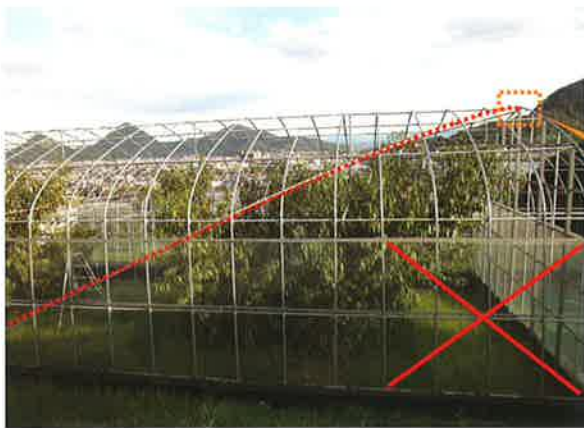
筋かい補強(点線)とクロス補強(実線)
