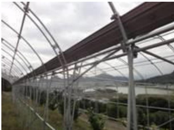
図8 ダブルアーチ工法による既存ハウスの補強
