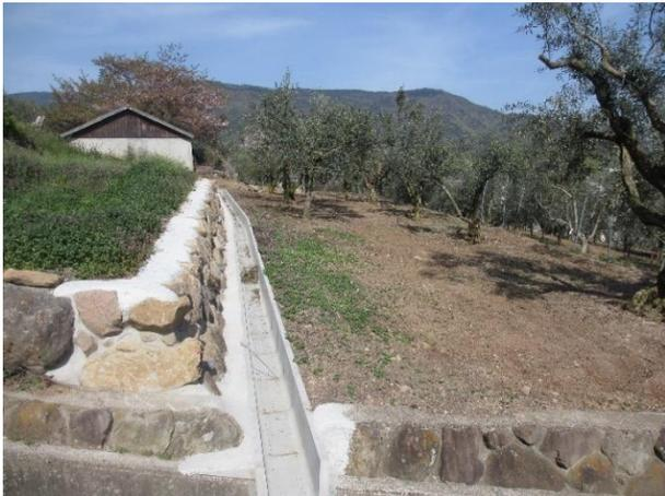
図4 圃場整備の状況（U字溝の整備）
