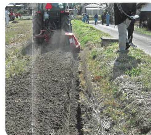
溝堀機による排水溝の設置
