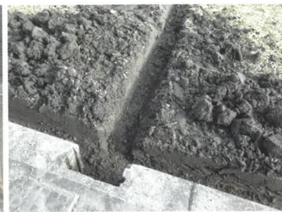
明きよは落水口へ接続
