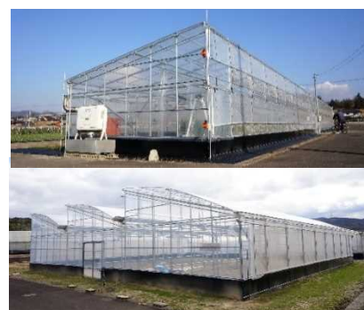
NNハウス (単棟低軒モデル:上 3連棟標準モデルアーチ型:下) <設計:西日本農研>
