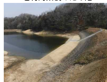
耐震対策後のため池
