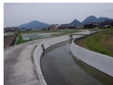
整備後の基幹水路
