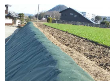
遊休農地発生防止のための簡易な整備（防草シート）
