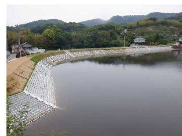
老朽対策後のため池
