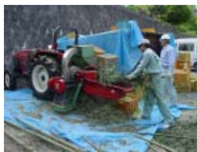
植織機による作業
