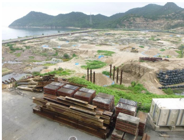
写真6 覆工板等撤去後
