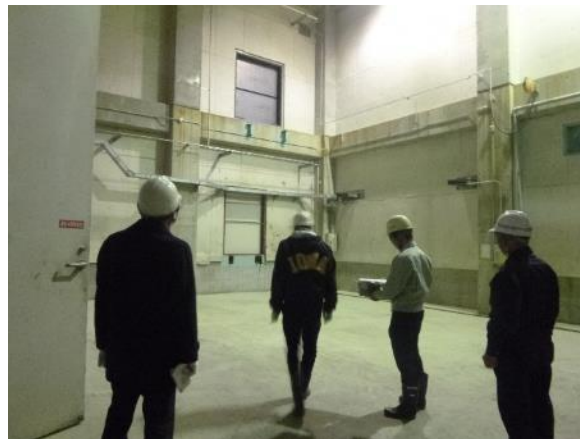
②北棟：粗破砕機解体撤去後の状況確認
