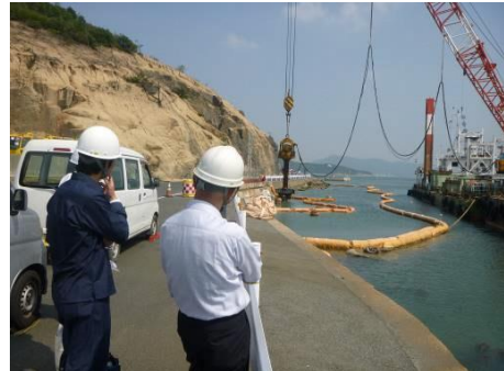
杭撤去作業の確認 (南より撮影)
