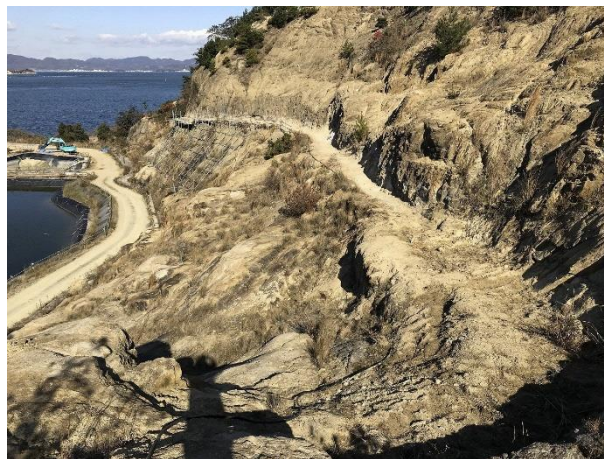
写真2 撤去後の状況 (H29.12.12撮影)
