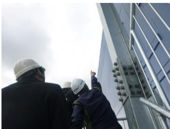
⑥北棟及び南棟の接合部の補修後の状況確認
