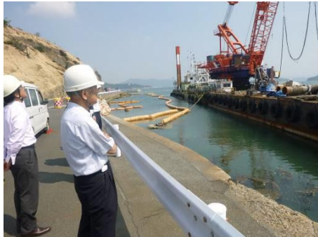
杭撤去作業の確認 (南より撮影)
