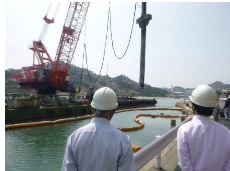
杭撤去作業の確認 (北西より撮影)
