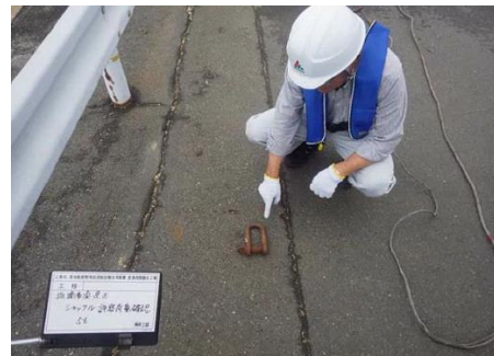
ワイヤースリングの安全確認
