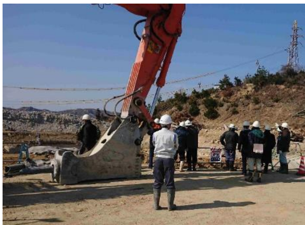
①ピットの解体状況の確認
