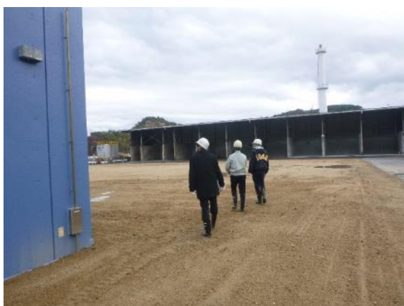
③南棟：躯体等解体撤去後の状況確認
