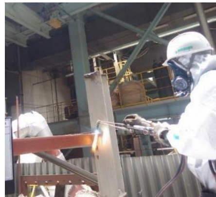
④レベル3 保護具の着用状況 (溶断時)
