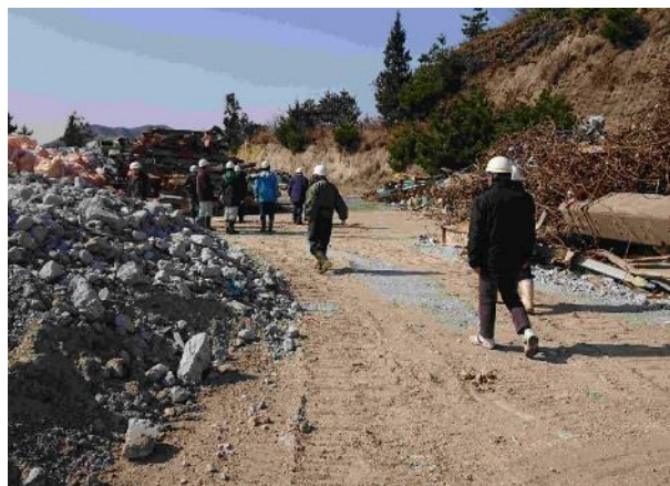
②施設撤去廃棄物等の保管状況の確認
