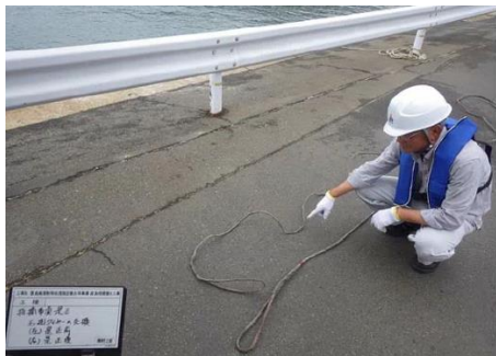
鋼管吊り上げ用のワイヤーの交換
