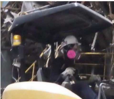
③レベル2 保護具の着用状況 (非溶断時)
