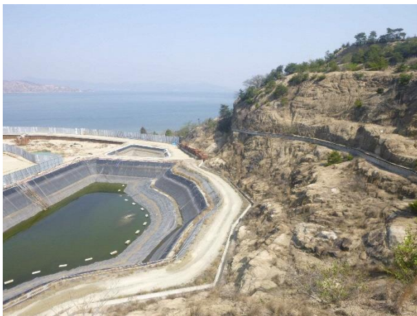
写真1 撤去前の状況 (H29.7.13撮影)
