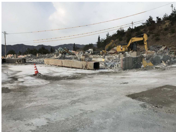
⑦躯体解体中（南東側から）H30. 1. 9 写真 1（続き） 豊島中間保管・梱包施設及び特殊前処理物処理施設の解体撤去工事の状況
