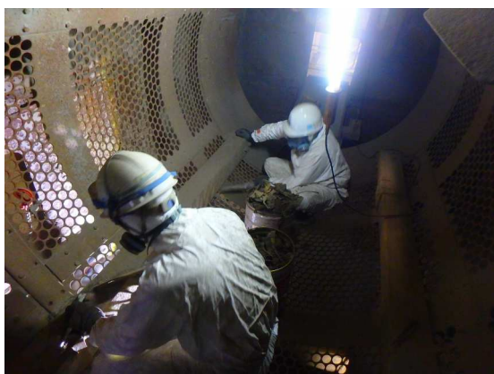
①可燃物粒度選別機の除去作業
