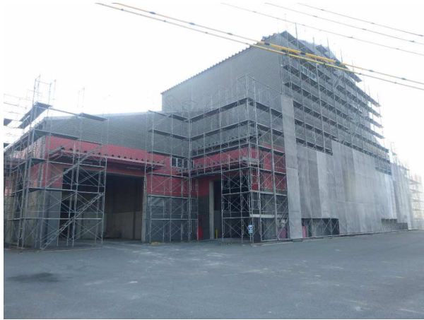
③外装解体の開始時（北西側から）H29. 12. 6
