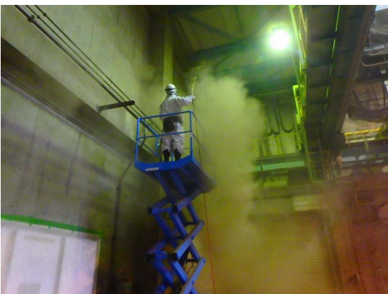
⑤建築構造物（梁・天井）の清掃作業
