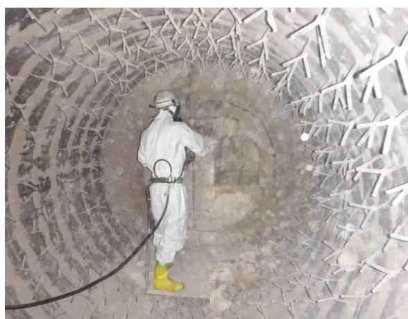
④ロータリーキルンの耐火物の除去作業
