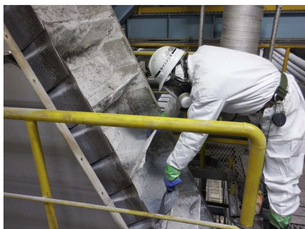
①投入コンベヤの除去作業
