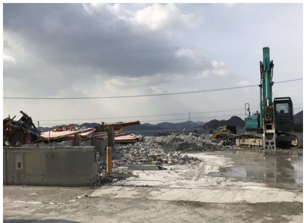
⑧躯体解体中（東側から）H30. 1. 9
