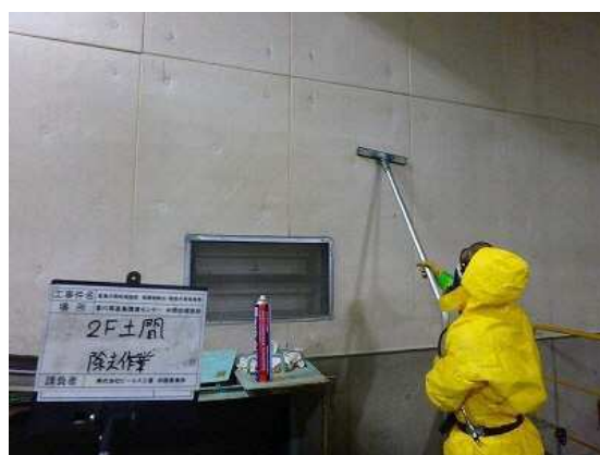
⑥建築構造物（壁）の清掃作業
