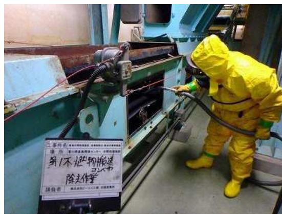
②第1不燃搬送コンベヤの除去作業
