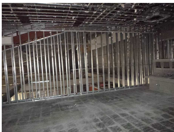
①内装解体後（操作室付近）H29. 12. 6
