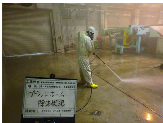
④建築構造物（床）の清掃作業
