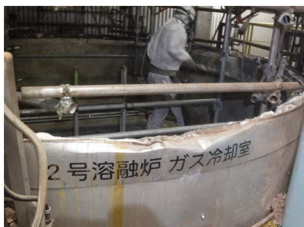
③溶融炉ガス冷却室の耐火物の除去作業
