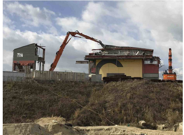
⑥外装解体中（東側から）H29. 12. 27
