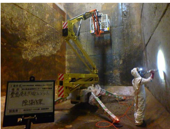
③ピットの除染作業
