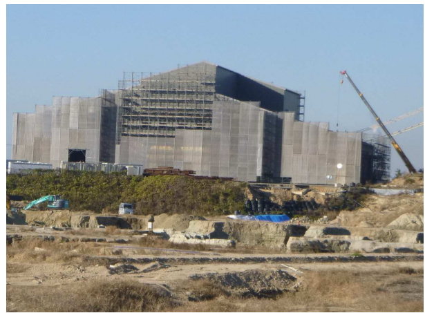
④外装解体の開始時（東側から）H29. 12. 6
