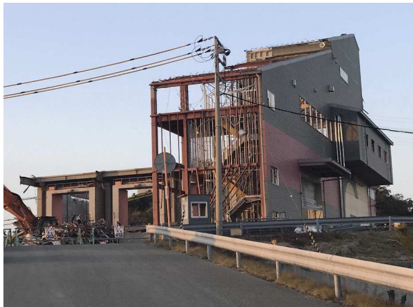
⑤外装解体中（南側から）H29. 12. 26
