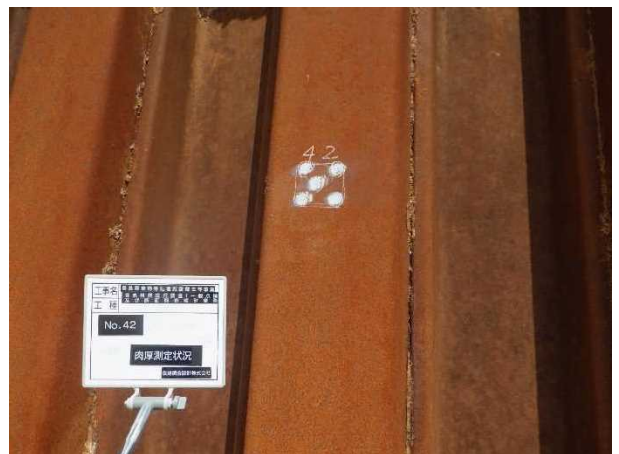
写真 6 肉厚測定箇所-研磨後 (No. 42)
