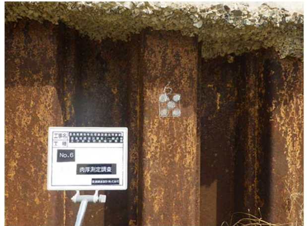
写真 2 肉厚測定箇所-研磨後 (No. 6)
