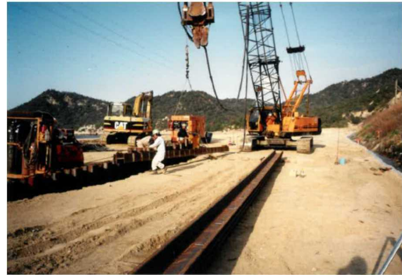
バイブロハンマによる打設状況【H12暫定的な環境保全措置工事（第1工区）】
