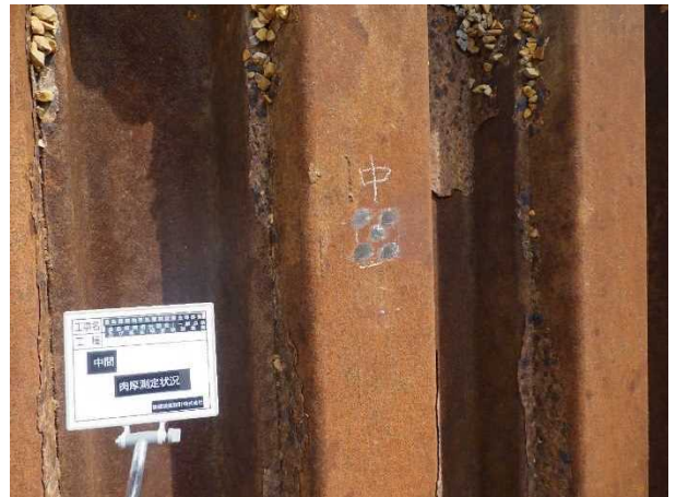
写真 4 肉厚測定箇所-研磨後 (中間)
