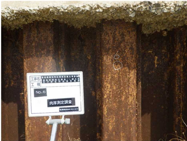
写真 1 肉厚測定箇所-研磨前 (No. 6)
