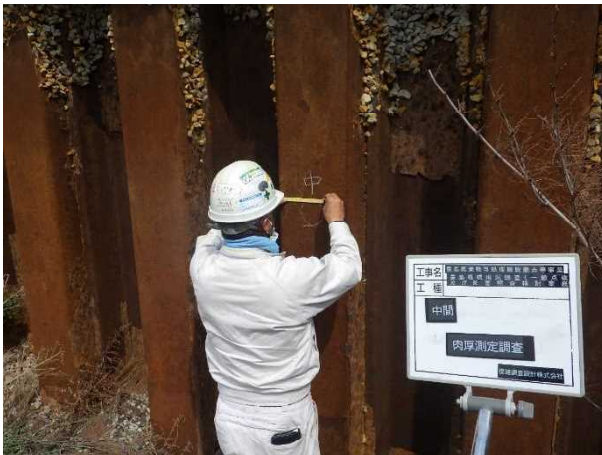
写真 3 肉厚測定箇所-研磨前 (中間)
