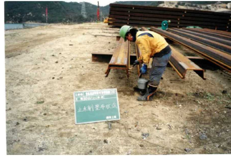
鋼矢板への止水材塗布状況【H12暫定的な環境保全措置工事（第1工区）】
