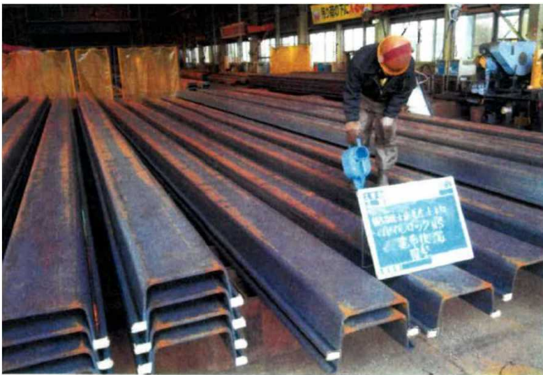
鋼矢板への止水材塗布状況【H27北海岸トレンチドレーン撤去及び仮設矢板設置工事（第1工区）】
