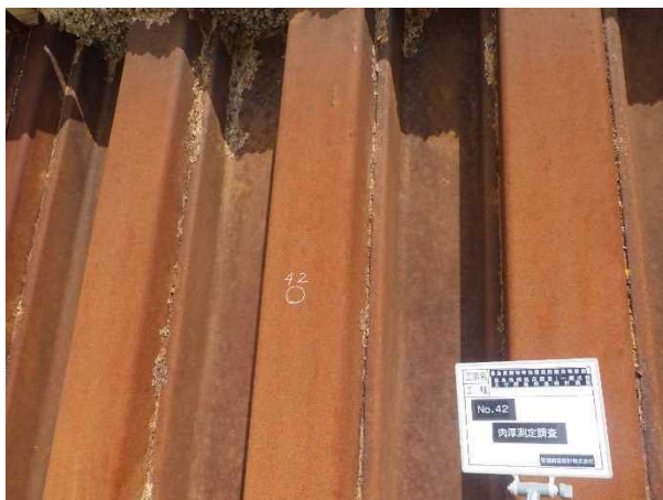
写真 5 肉厚測定箇所-研磨前 (No. 42)
