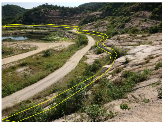
写真3 下流側の排水路
