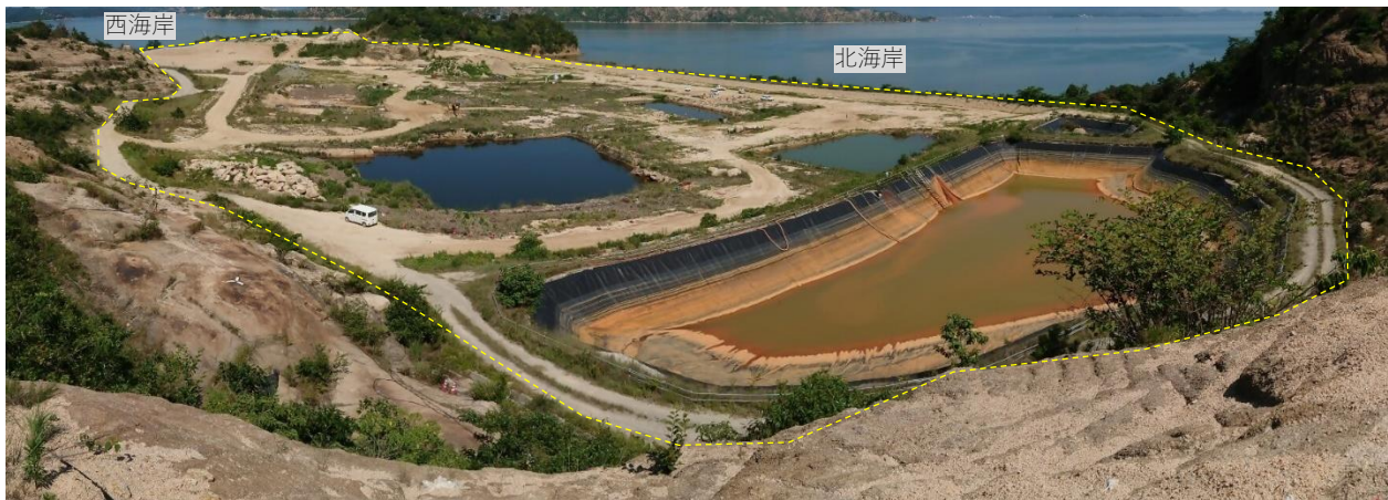
写真2 処分地内の整地の範囲（東より広角撮影）
