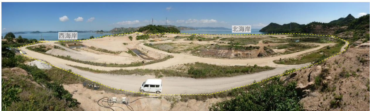
写真1 処分地内の整地の範囲（南より広角撮影）
