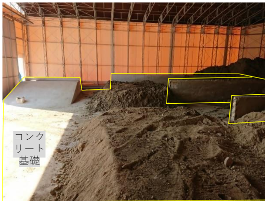
写真1 積替え施設 (下部)
