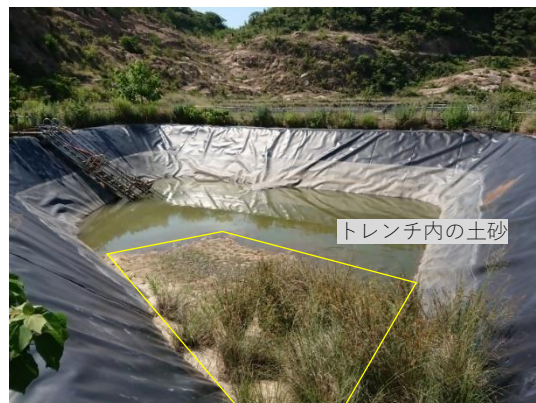
写真2 新貯留トレンチ
