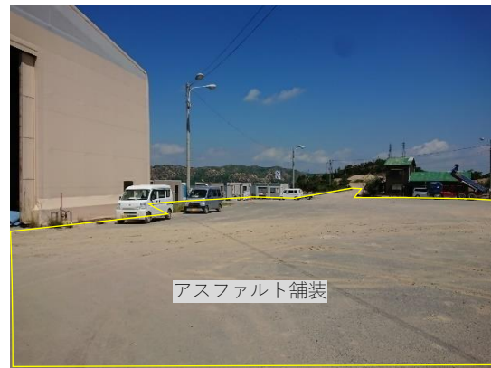
写真2 処分地内道路部
