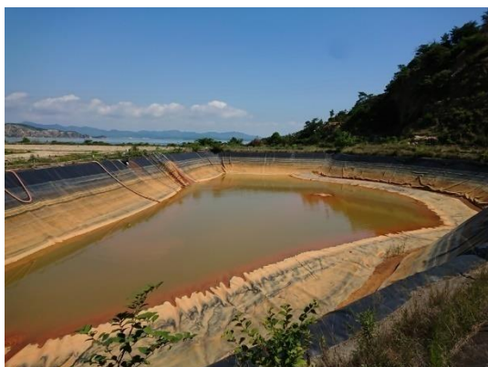
写真1 貯留トレンチ
