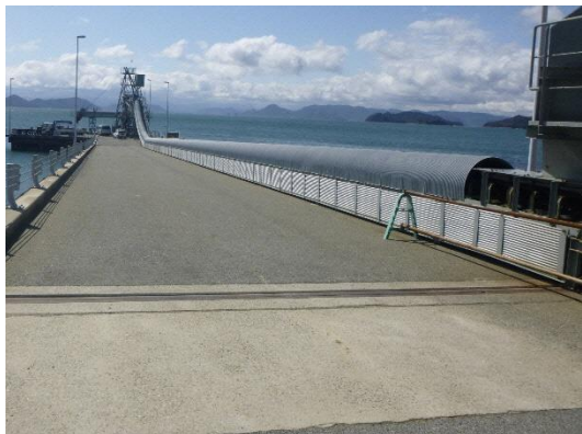
写真1 ベルトコンベア（陸側）
