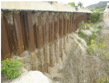
写真1 遮水壁及びトレンチドレイン
