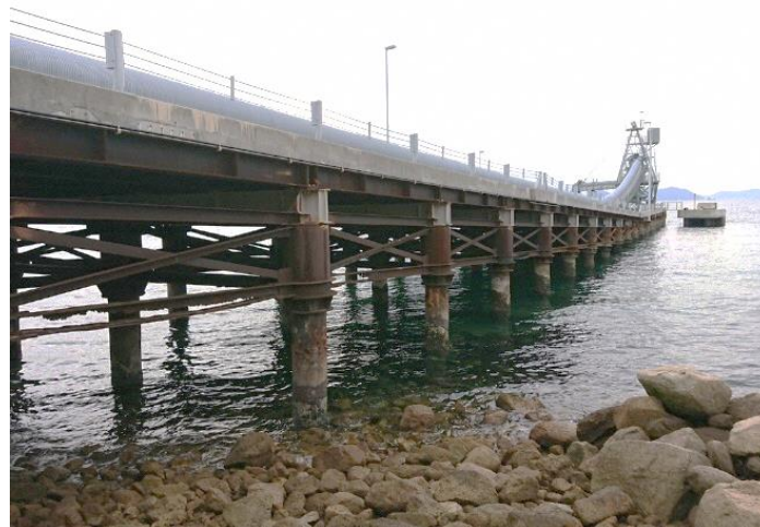
写真2 豊島専用栈橋（近景）
