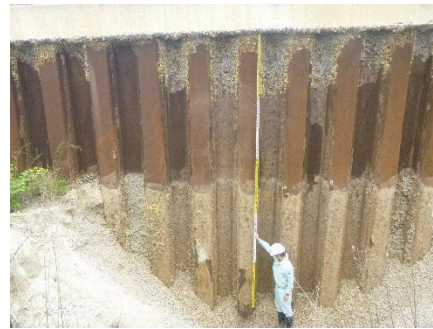
写真2 トレンチドレイン (試掘時の状況)
