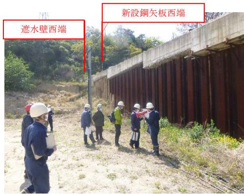
写真3 遮水壁西端部
