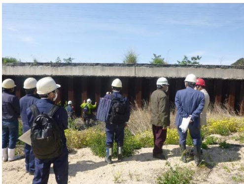
写真1 遮水壁側面部
