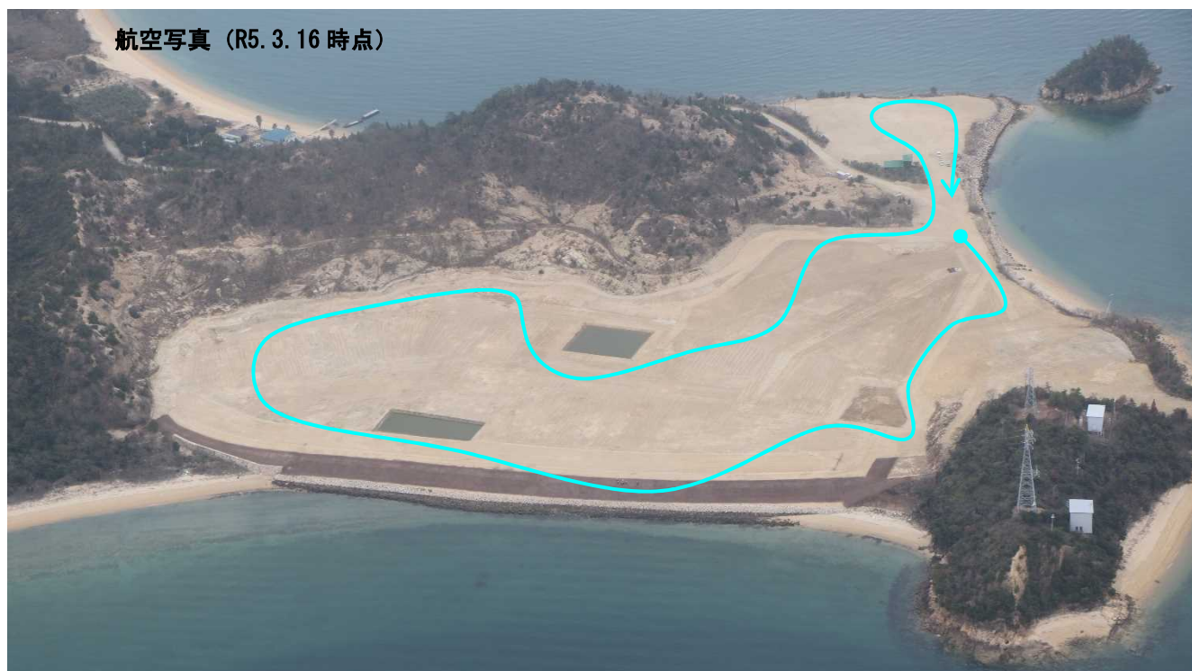
図Ⅸ-1 現地確認ルート
