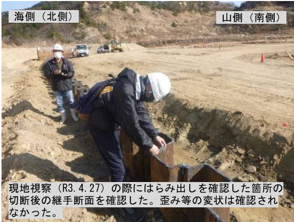
写真IV-9 接手部の切断状況の確認
