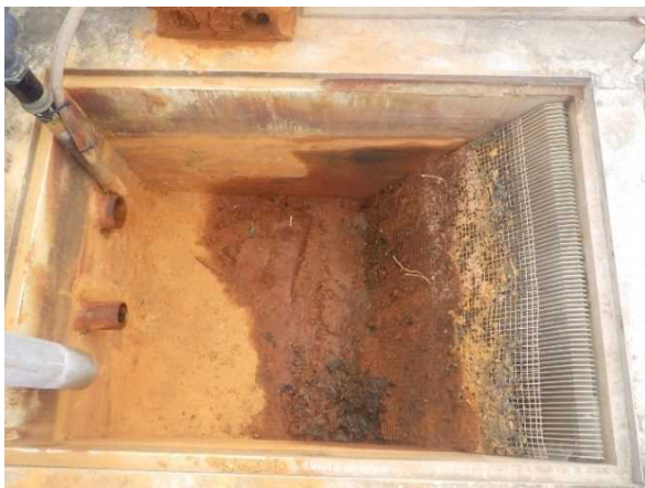
写真Ⅲ-1 高度排水処理施設（沈砂層）洗浄前
