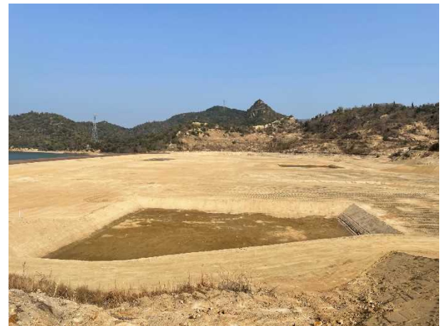
写真VI-6 浸透池（D側線西側）の改修後の状況
