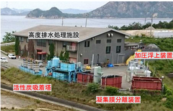
写真Ⅲ-5 簡易地下水処理施設 解体・撤去前
