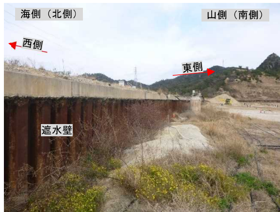
写真IV-3 遮水壁撤去前（処分地側（東向き））
