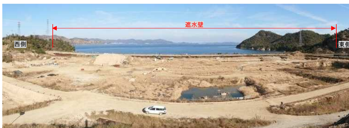
写真IV-1 引抜き前の処分地内の状況 (令和3年11月29日)
