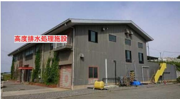
写真Ⅲ-3 高度排水処理施設 解体・撤去前
