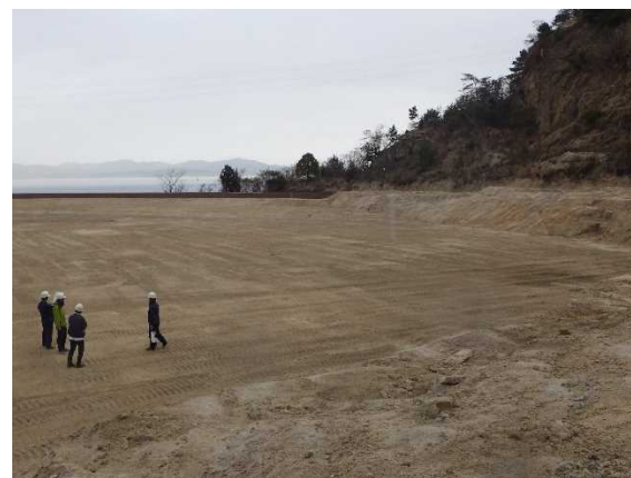
撤去後の確認状況 (R5. 3. 16)
