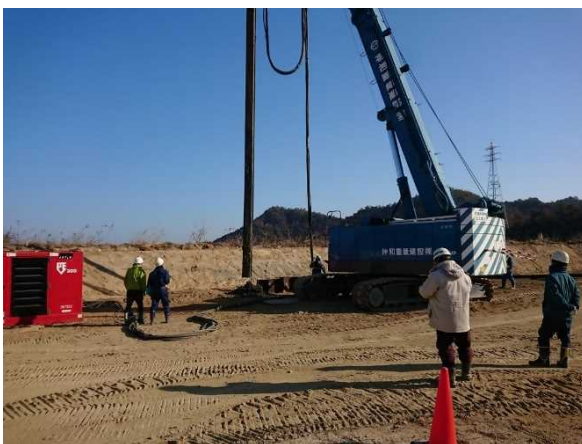
写真IV-11 引抜き状況の確認
