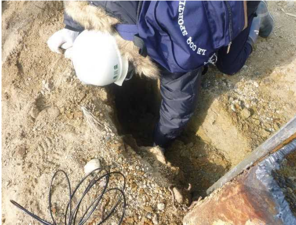
写真IV-7 引抜き跡の確認
