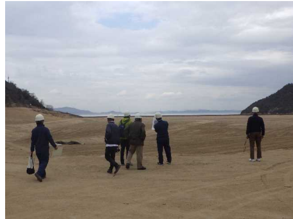
撤去後の確認状況 (R5. 3. 16)
