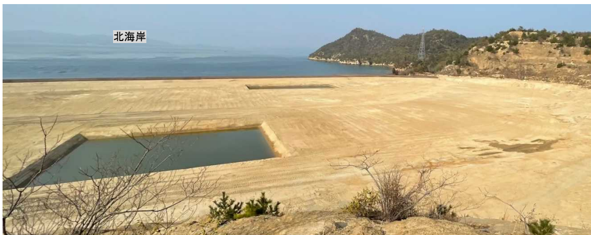
写真Ⅵ-2 処分地の整地関連工事後の状況（南側から撮影）
