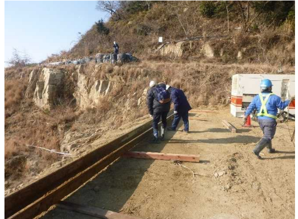
写真IV-8 引抜き後の鋼矢板の確認
