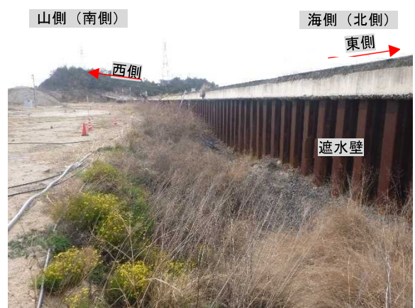
写真IV-4 遮水壁撤去前（処分地側（西向き））
