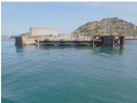
写真V-3 栈橋撤去前（海側から撮影）
