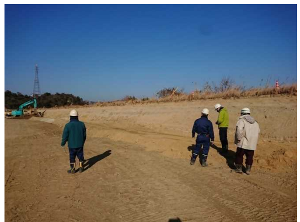
写真IV-12 引抜き後の締め固め状況の確認
