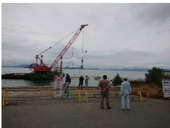
写真V-7 鋼管杭撤去作業の確認
