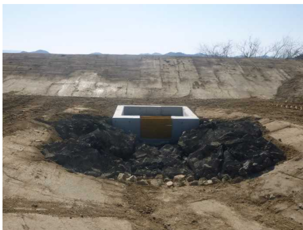
写真VI-5 導水管呑口部の改修後の状況
