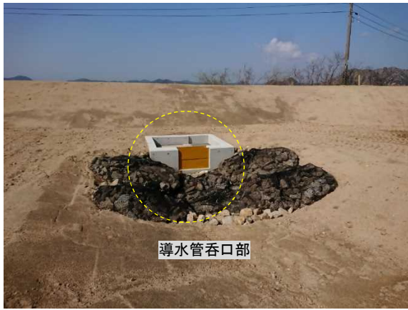
写真区-13 ⑥-4-4 導水管呑口部
