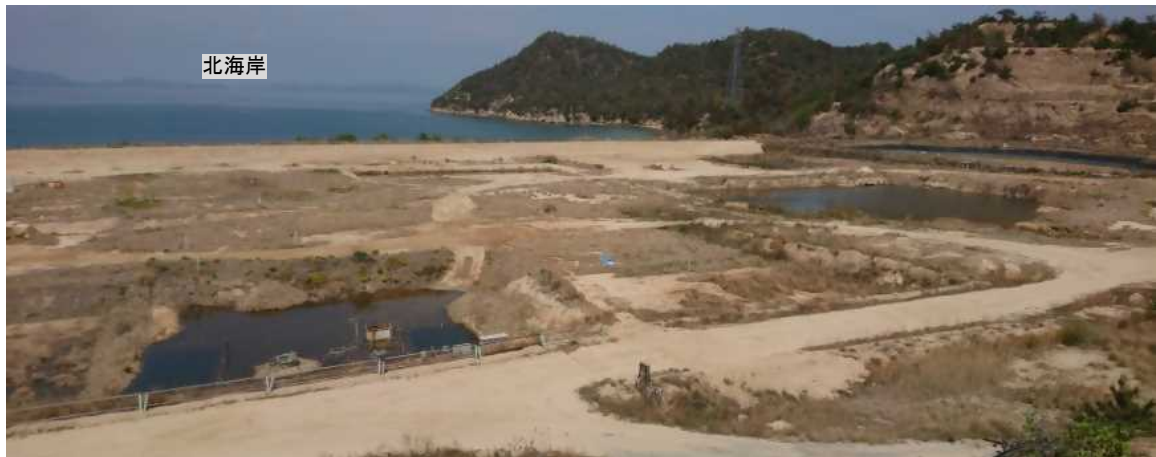
写真Ⅵ-1 処分地の整地関連工事前の状況（南側から撮影）
