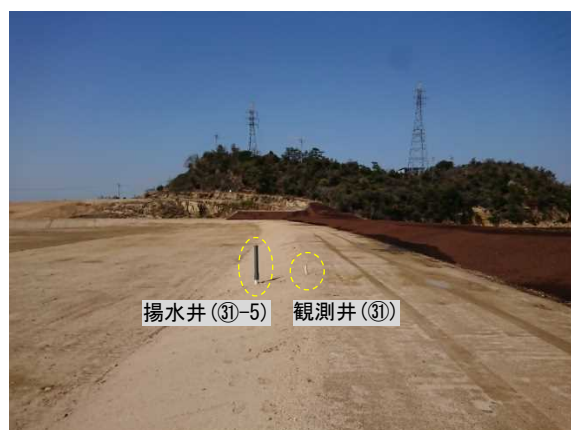
写真IX-9 揚水井及び観測井 (区画 31 周辺)
