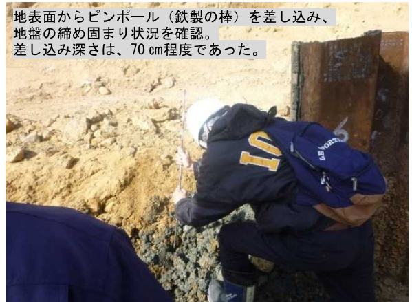
写真IV-10 引抜き跡の確認（締め固まり状況）
