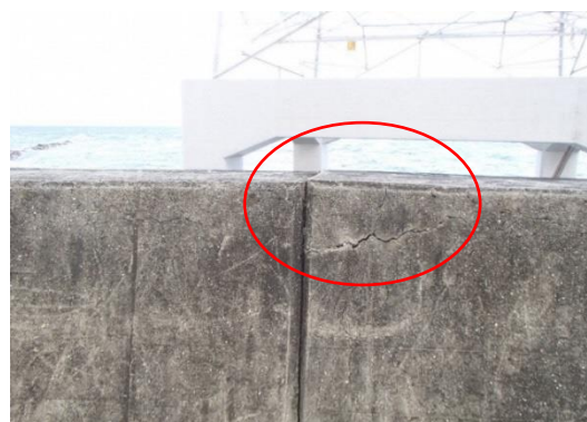
写真6 参考:アルカリ骨材反応の特徴的な状況(2)
