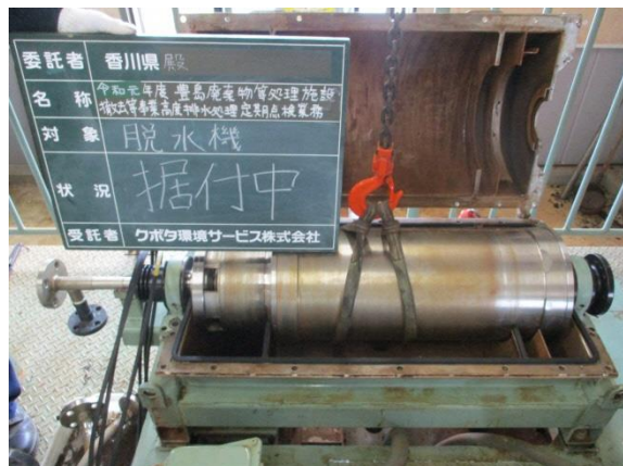
写真12 脱水機 整備状況
