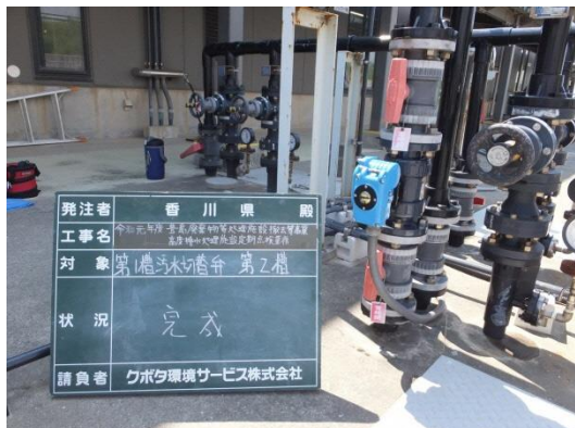
写真16 第1槽 切替弁交換完了
