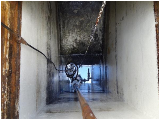
写真5 沈砂槽 清掃完了
