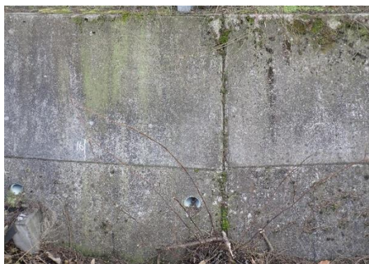
写真1 H16-01 擁壁 (既往調査時)
