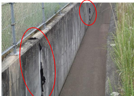
写真5 参考:アルカリ骨材反応の特徴的な状況(1)
