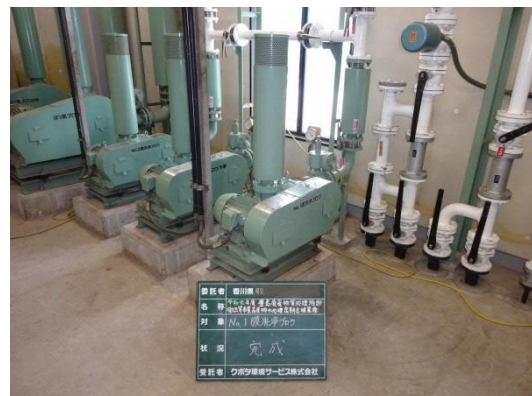
写真 15 膜洗浄ブロワ 整備完了
