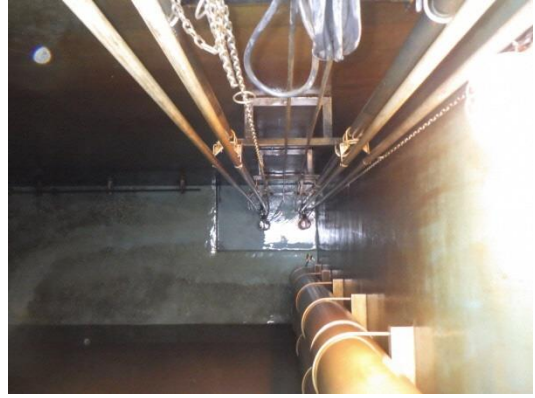
写真4 第5槽（多目的槽2） 清掃完了
