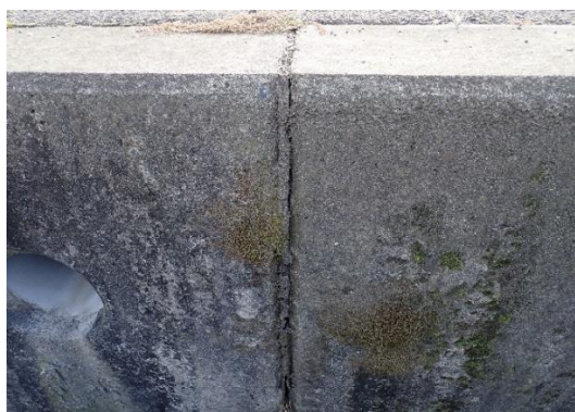
写真3 H16-03 擁壁 (既往調査時)
