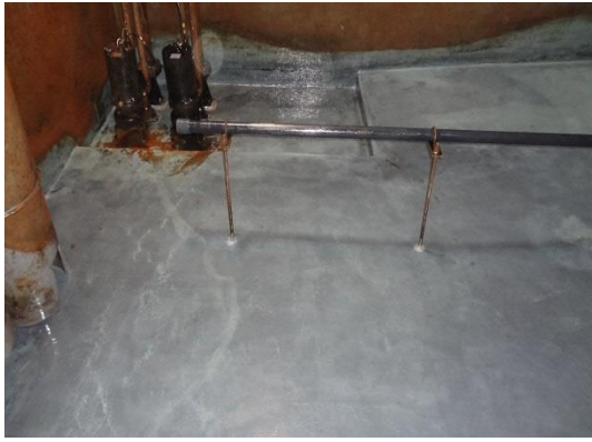
写真3 第3槽（貯留槽） 清掃完了
