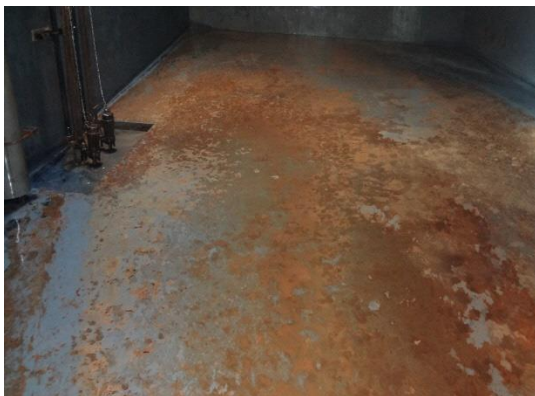
写真1 第1槽（流入槽）清掃完了
