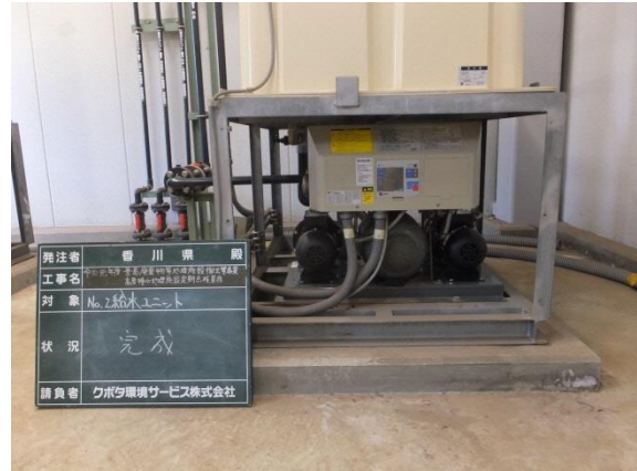
写真 13 給水ユニット 整備完了
