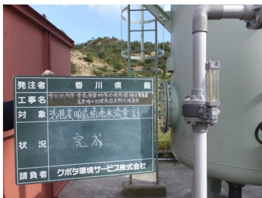
写真18 活性炭処理装置 流量計交換完了
