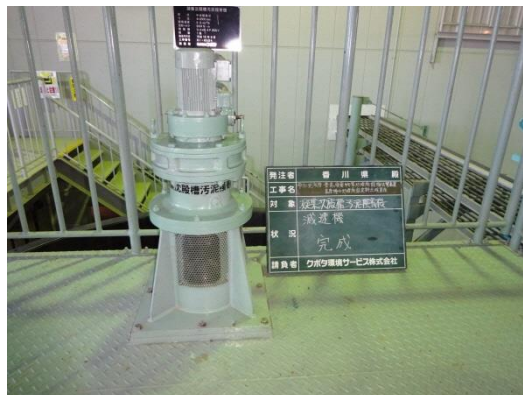
写真8 凝集沈殿槽 整備完成
