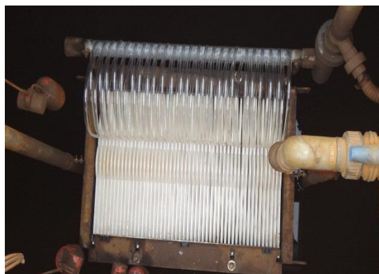
写真17 凝集膜ろ過装置 整備完了
