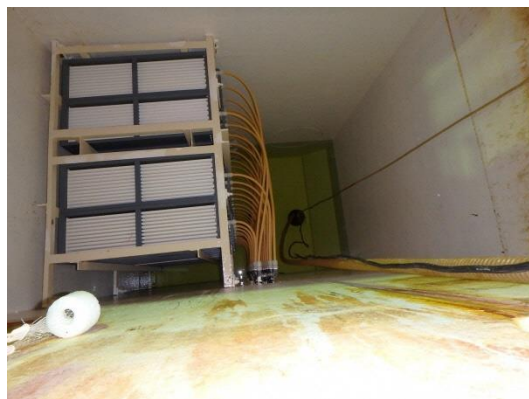
写真9 セラ膜1号機 洗浄完了
