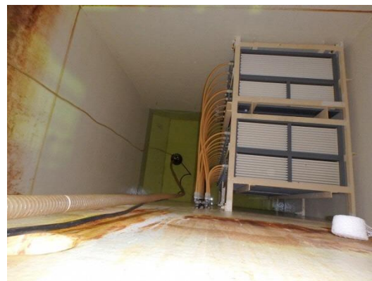
写真10 セラ膜2号機 洗浄完了
