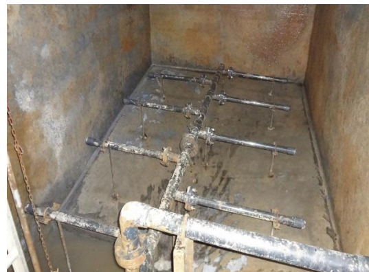
写真2 第2槽（ばっ気槽）清掃完了
