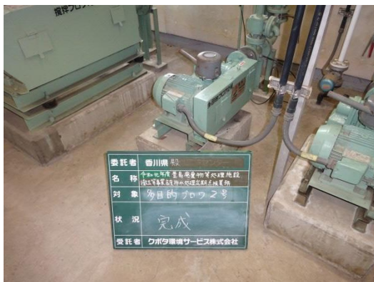
写真 14 多目的ブロワ 整備完了
