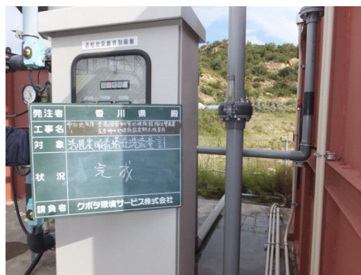
写真18 活性炭処理装置 流量計交換完了
