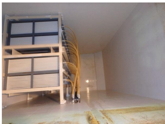
写真3 セラミック膜1号機 洗浄完了
