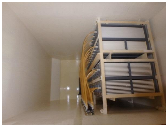
写真4 セラミック膜2号機 洗浄完了
