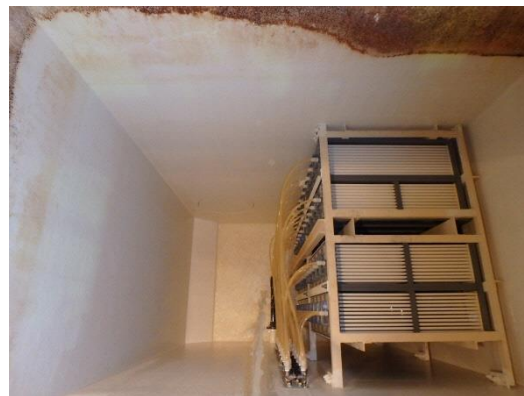
写真2 セラミック膜2号機 洗浄完了
