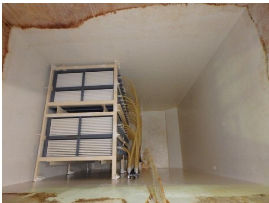
写真1 セラミック膜1号機 洗浄完了
