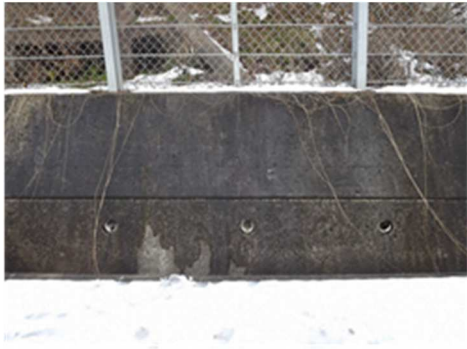
写真1 H16-01 擁壁 (既往調査時)
