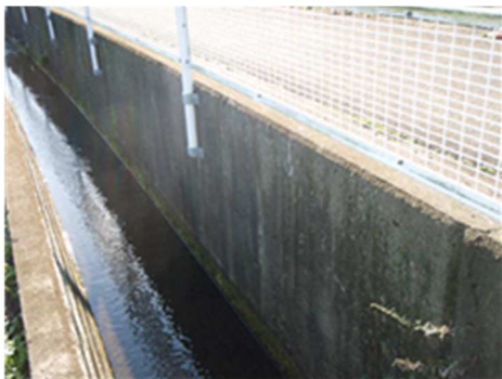
写真3 H16-03 擁壁 (既往調査時)
