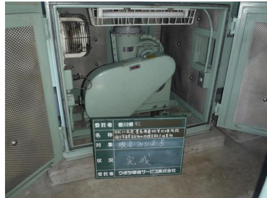
写真6 脱臭ファン 整備完成
