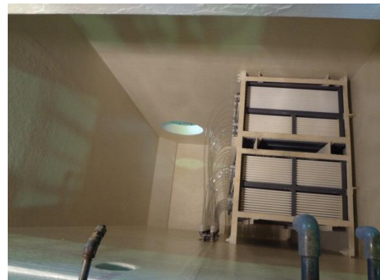
写真8 セラ膜2号機 洗浄塗装完了
