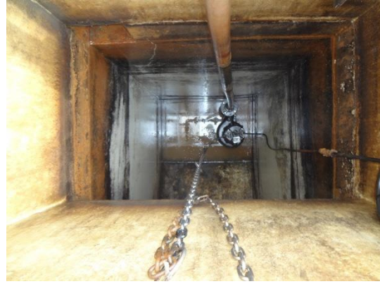
写真4 沈砂槽 清掃完了
