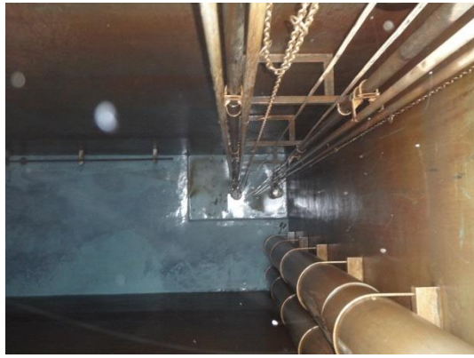
写真3 第5槽（多目的槽2） 清掃完了
