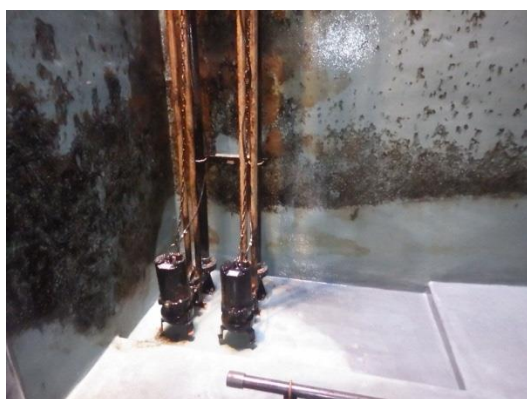
写真 1 第 3 槽 (貯留槽) 清掃完了
