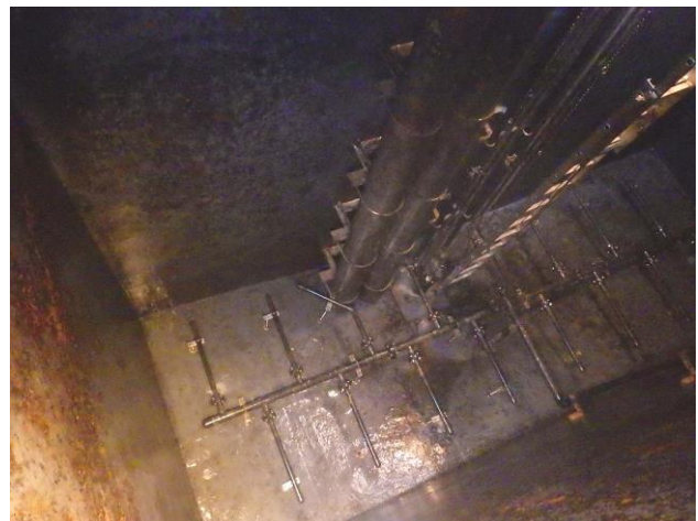
写真2 第2槽（曝気槽）清掃後
