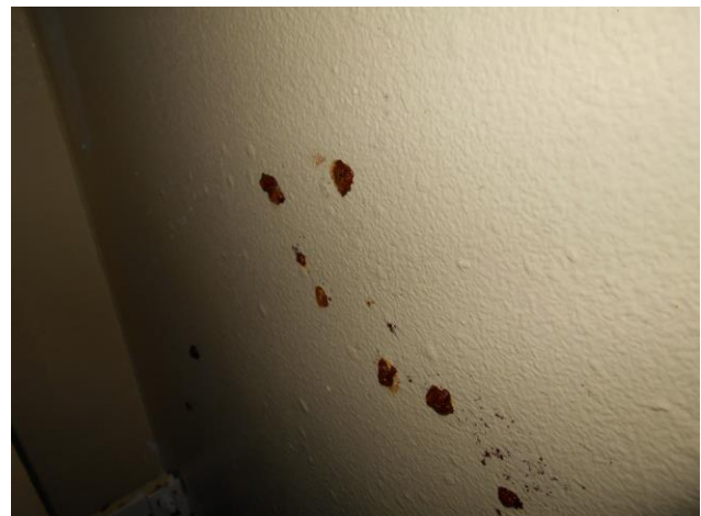
写真4 水槽上部 錆発生部
