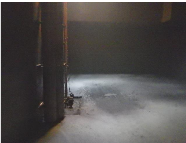
写真1 第1槽（流入槽）清掃後
