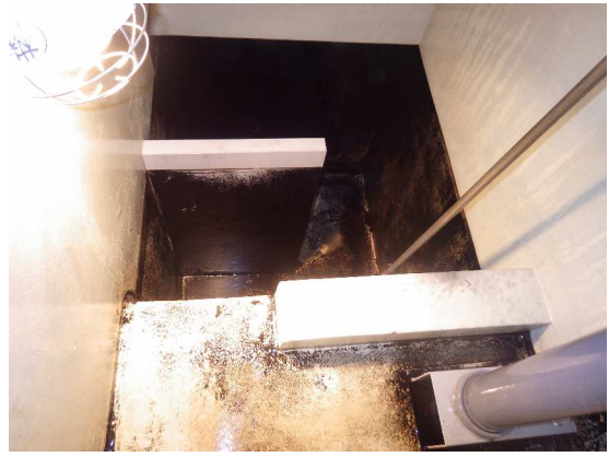
写真 7 消毒槽 清掃後
