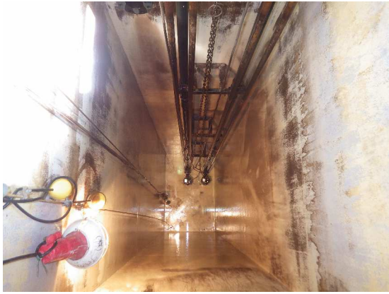
写真 4 活性炭吸着原水槽 清掃後
