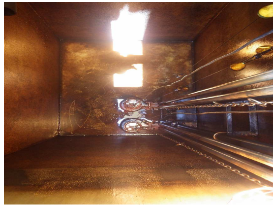
写真 9 放流ピット 清掃後
