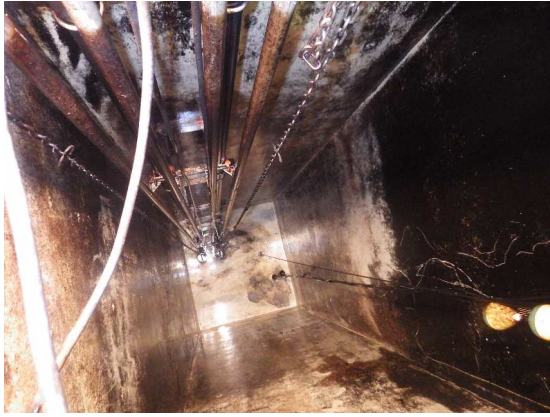
写真 2 膜ろ過原水槽 清掃後
