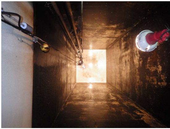
写真 6 処理水槽 清掃後
