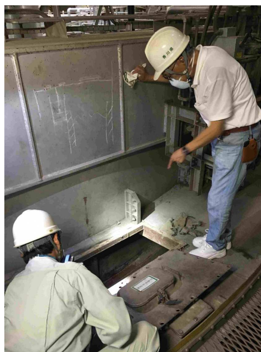
②熔融炉の廃棄物供給塔内の確認
