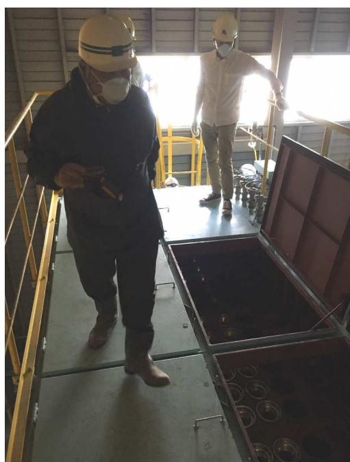
④バグフィルタの確認
