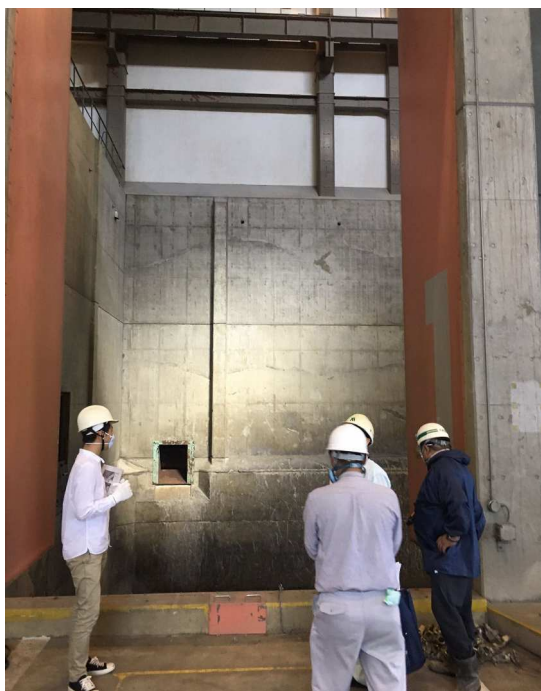
①保管ピットの確認
