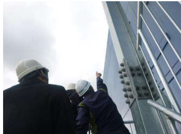
⑥北棟及び南棟の接合部の補修後の状況確認
