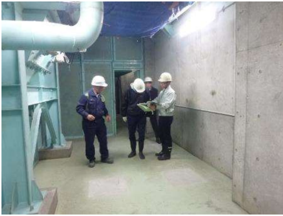
①北棟：粗大物搬送コンベヤ解体撤去後の状況確認
