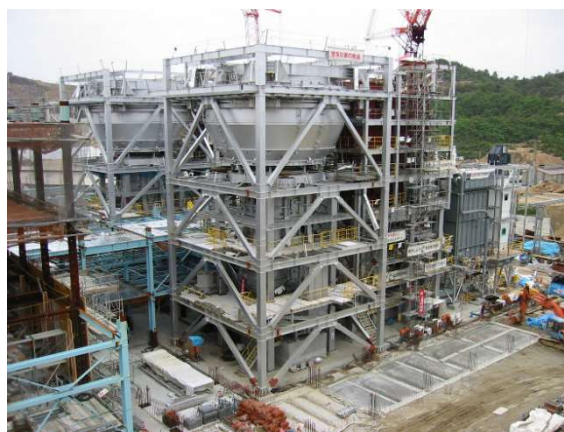
写真 3-6-2-3-2 回転式表面熔融炉（工事中の写真）
