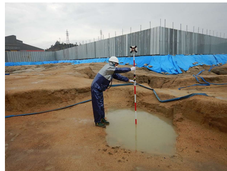
写真3-4-3-10 水面部の点群補測
