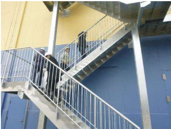
⑤北棟及び南棟の接合部の補修後の状況確認
