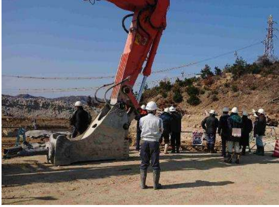
写真3-15-1-1-1 ピットの解体状況の確認
