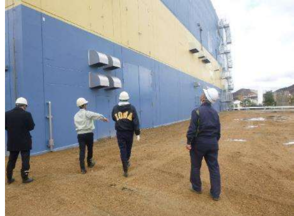
④北棟及び南棟の境界壁修復工事後の状況確認
