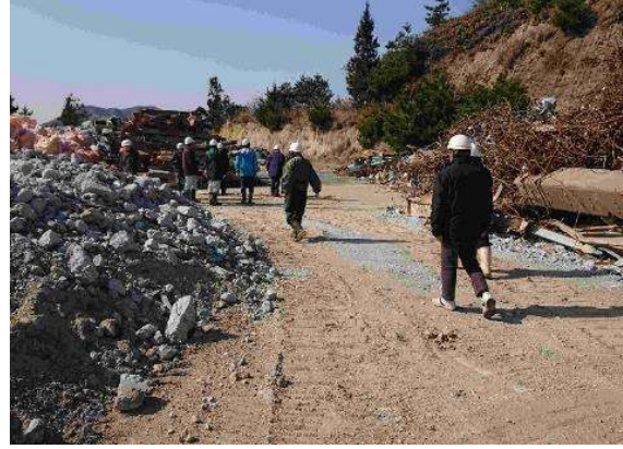
写真3-15-1-1-2 施設撤去廃棄物等の保管状況の確認
