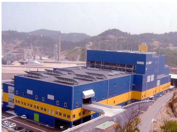
写真 3-6-2-3-1 中間処理施設全景
