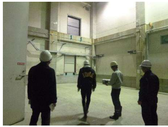
②北棟：粗破碎機解体撤去後の状況確認
