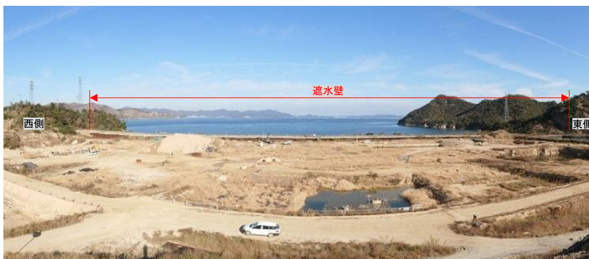
写真 1 引抜き前の処分地内の状況（令和 3 年 11 月 29 日）
