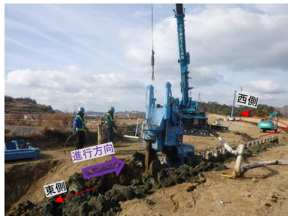
写真8 油圧圧入引抜機による引抜き状況
