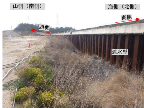
写真4 遮水壁処分地側（西向き）
