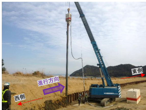
写真7 バイブロハンマによる引抜き状況
