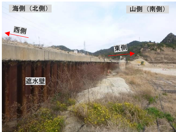
写真3 遮水壁処分地側（東向き）
