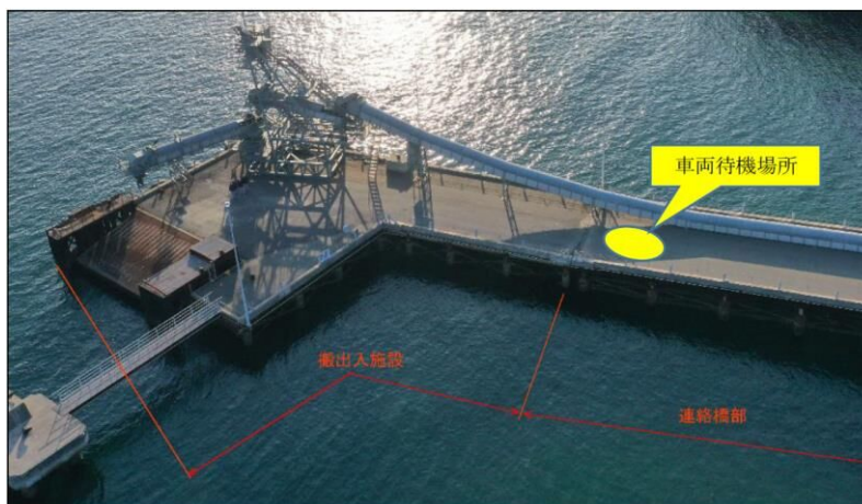
写真1 専用棧橋利用時の車両待機場所
