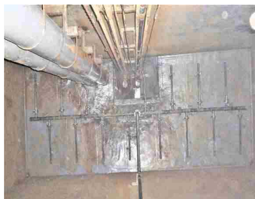
写真2 第2槽（ばっ気槽） 清掃完了
