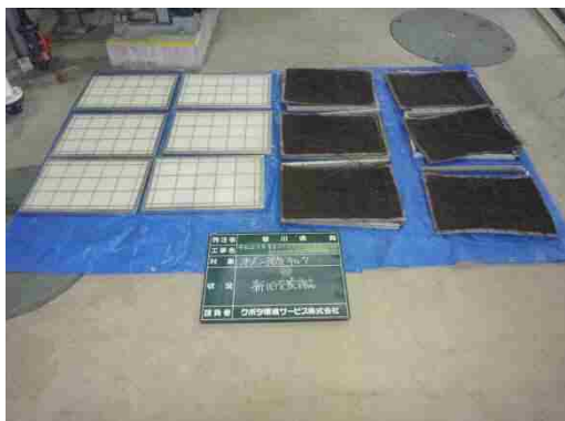
写真12 給気フィルタ 新旧部品
