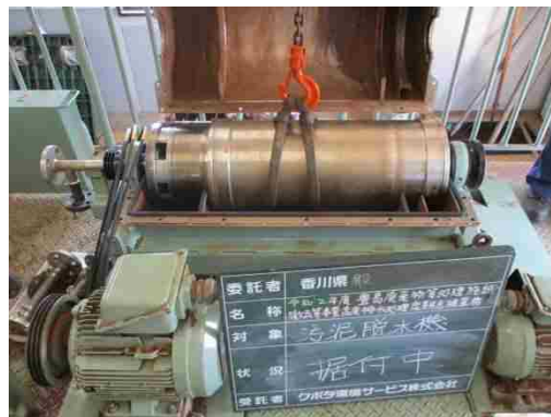
写真8 汚泥脱水機 整備状況
