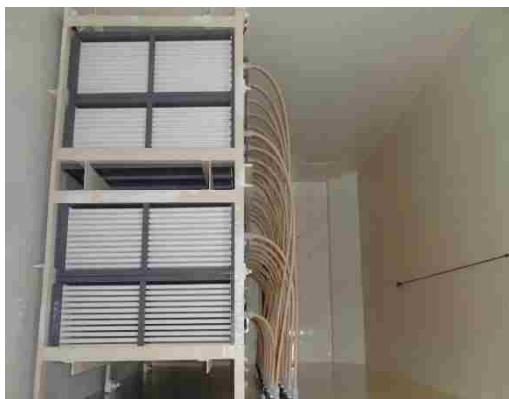
写真6 セラミック膜1号機 洗浄完了
