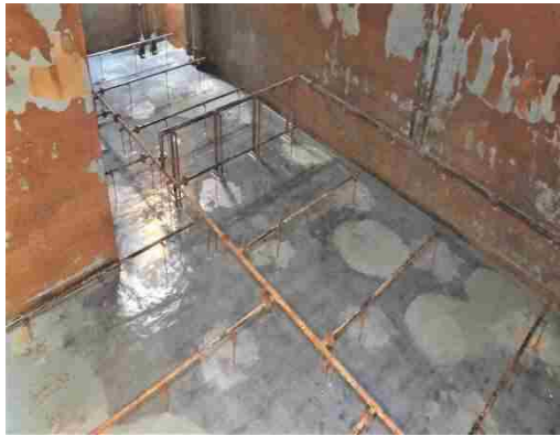
写真3 第4槽（多目的槽1） 清掃完了
