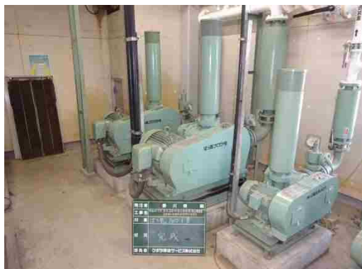
写真9 ばっ気ブロワ1号 整備完了
