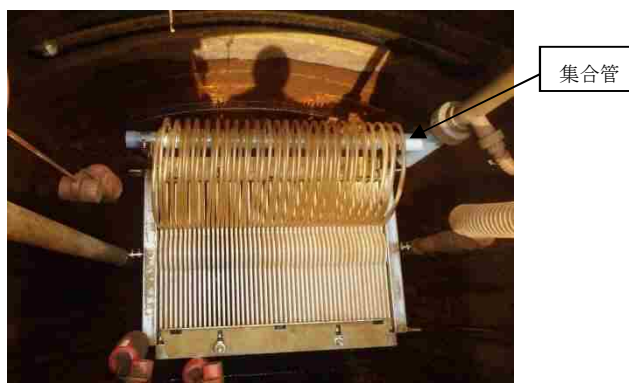
写真 11 集合管 交換完了
