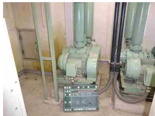
写真10 ばっ気ブロワ2号 整備完了
