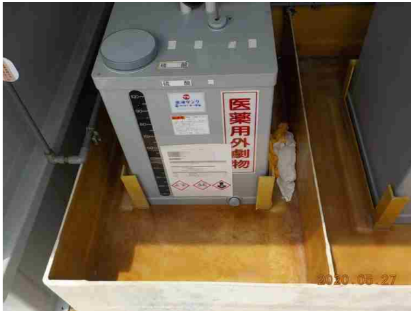
薬品廃液 回収後、水洗い清掃 実施
