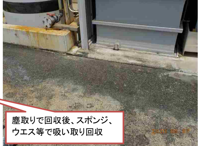
防液堤内硫酸回収状況
