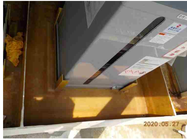
薬品廃液 回収後、水洗い清掃 実施
