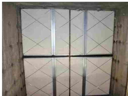
写真13 給気フィルタ 交換完了
