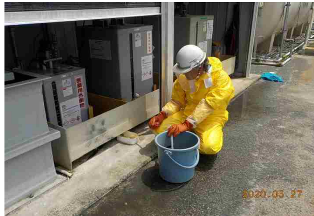
硫酸・苛性ソーダ防液堤内、ふき取り清掃
