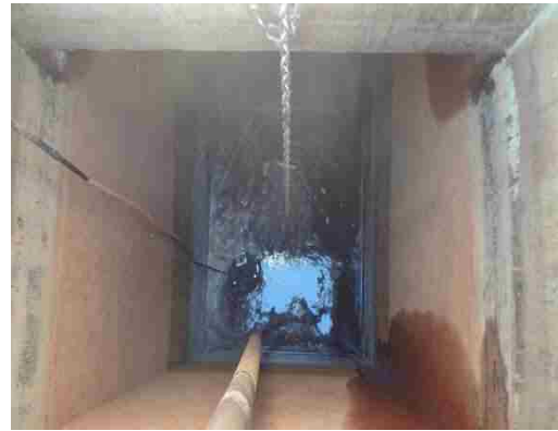
写真4 沈砂槽 清掃完了
