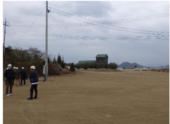
撤去後 (R5. 3. 16 現地確認)
