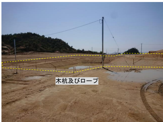
写真 25 浸透池 (木杭及びロープの設置状況)
