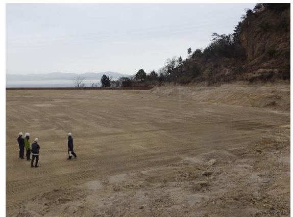
撤去後 (R5. 3. 16 現地確認)
