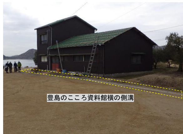
写真 22 ⑥-4-5 豊島のこころ資料館横の側溝
