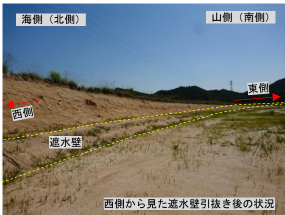
遮水壁引抜き後の状況 (処分地側 (東向き))
