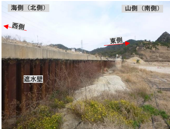
遮水壁付近撤去前 (処分地側 (東向き))
