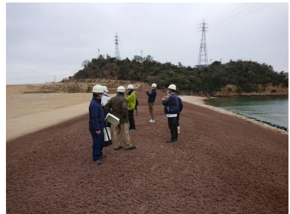
撤去後 (R5. 3. 16 現地確認) (処分地側 (西向き))
