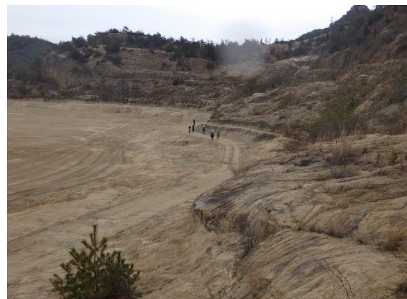
撤去後 (R5. 3. 16 現地確認)
