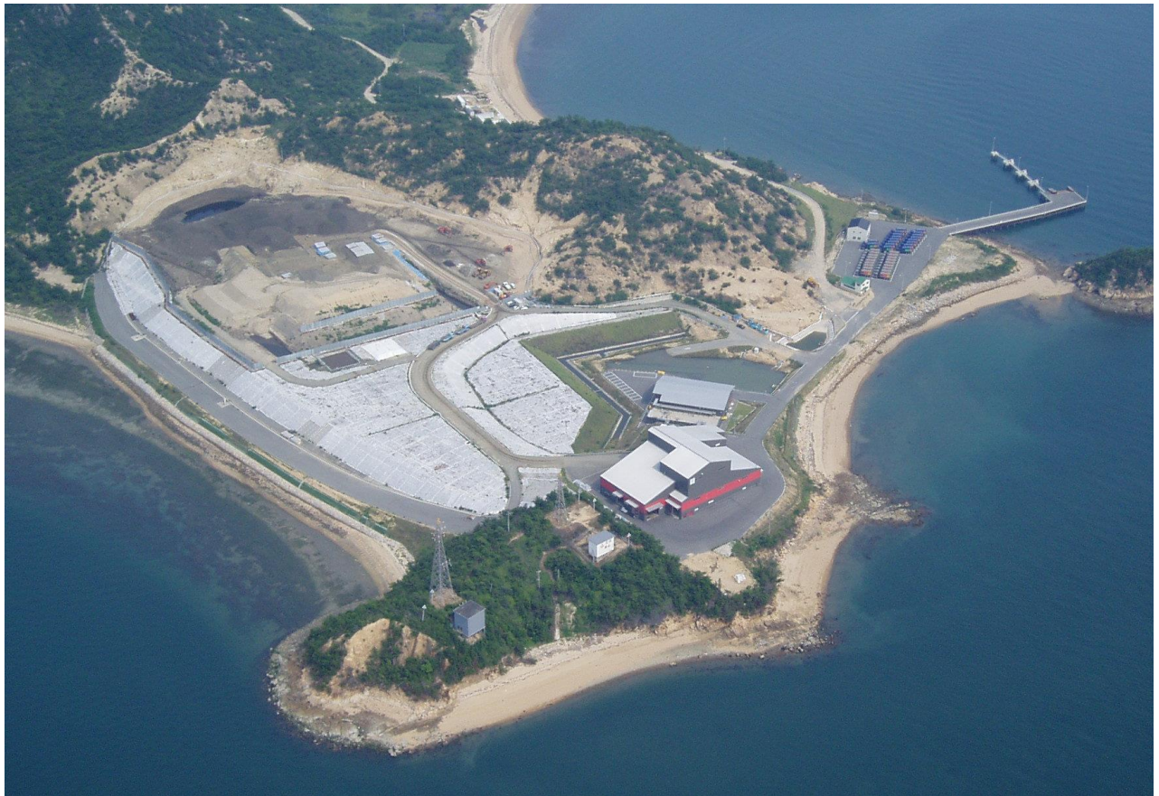
写真 27 豊島廃棄物等の搬出中の状況（平成 17 年 7 月）
