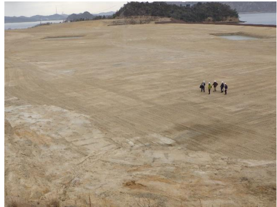
R5.3.16 現地確認（東側から撮影）
