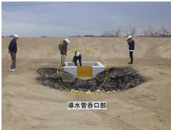
写真 21 ⑥-4-4 導水管呑口部
