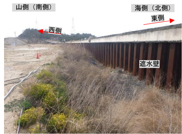
遮水壁付近撤去前 (処分地側 (西向き))
