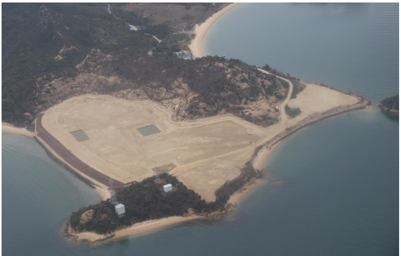
写真 28 整地後の状況（令和 5 年 3 月）
