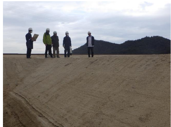
撤去後 (R5. 3. 16 現地確認)
