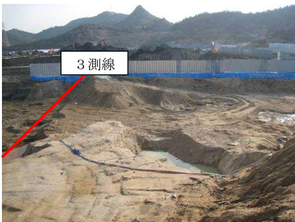
写真3 3測線南側の状況 (3+30より北側)
