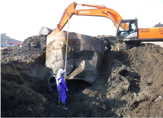
写真3 鉄製タンクの掘削状況
