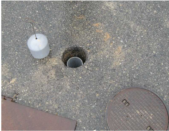
写真5 揚水井A3設置状況
