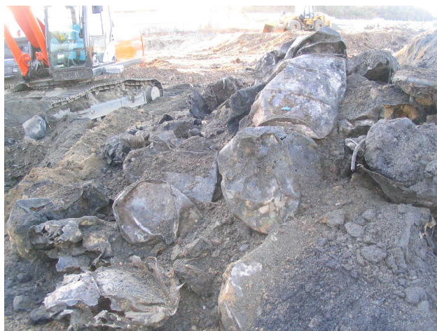
写真2 掘削されたドラム缶
