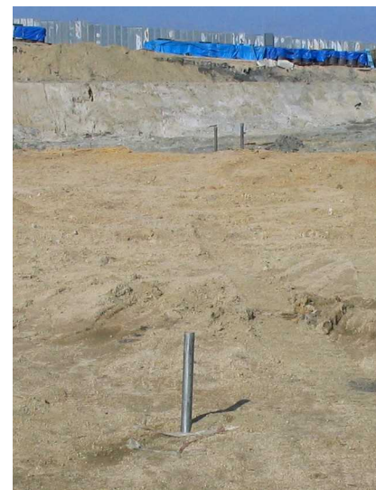
写真6 地点(C, 3+20)に打設したパイプ管 (奥に見える2本はC3北・南観測井)
