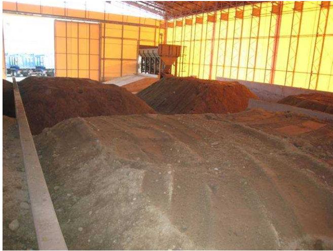
写真5 積替え施設での掘削後調査の状況
