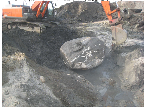
写真4 掘削された転石
