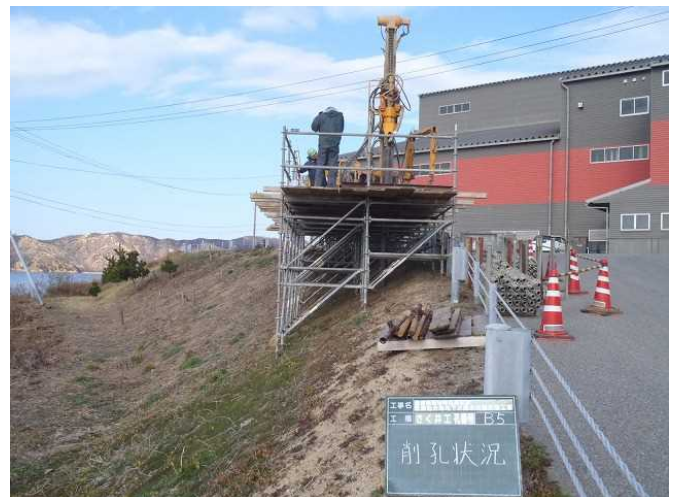
写真 4 B 5 削孔状況
