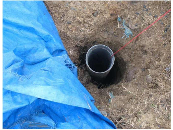
写真6 揚水井B5設置状況
