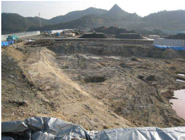
写真1 3測線北側の状況 (2+20より北側)
