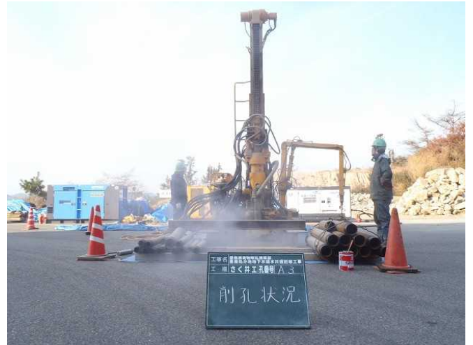
写真 2 A 3 削孔状況
