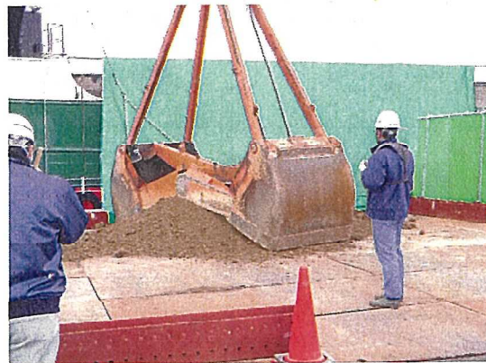
輸送船クレーンでの輸送船への積み込み
