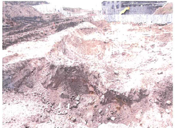
写真3 C3 地点より南側の掘削状況
