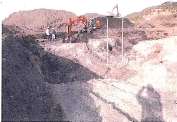
写真2 C3 地点より北側の掘削状況
