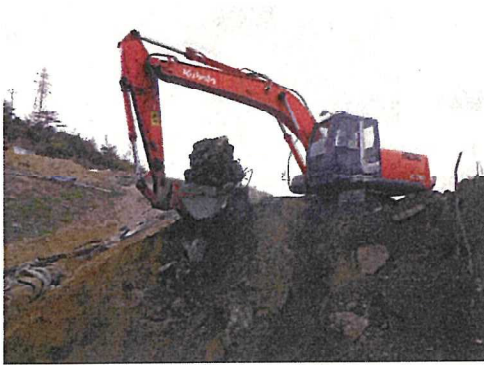
写真7 コンクリート殻の掘削状況
