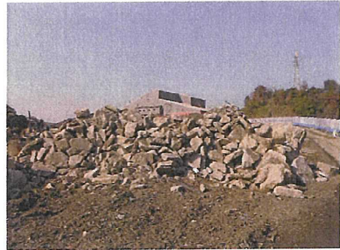
写真8 掘削されたコンクリート殻
