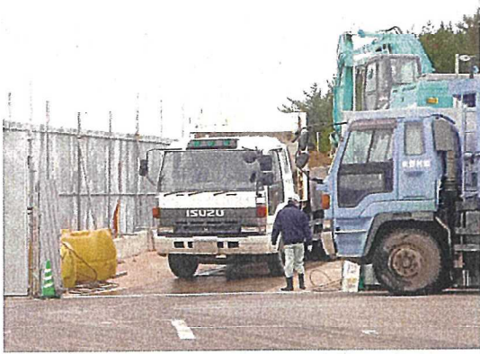
ダンプへの積み込み
