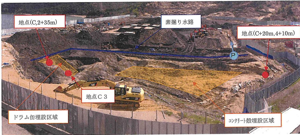
写真1 底面掘削の状況
